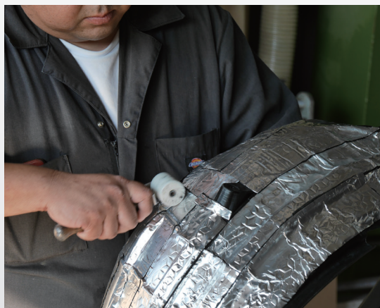
貼り付け時のポイントはインナーフェンダーにピッタリと圧着させることです。ローラーなどを使いしっかりと圧着させてください。
